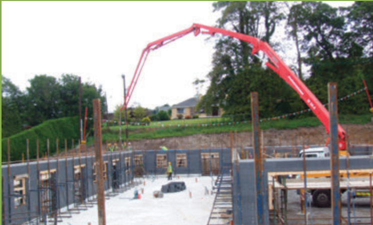
Concrete pour to ICF Walls
