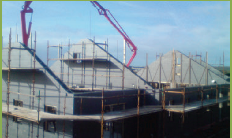
Concrete pour to ICF Walls
